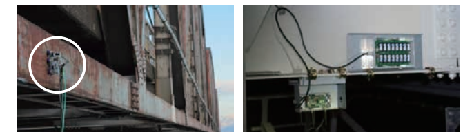
アクセス困難な部位での点検・非破壊評価・振動計測を目指した検討の例 (ロボティクス) Example of inspections, non-destructive evaluations, and vibration measurements for sections difficult to access (Robotics) 橋梁等実スケール構造物の計測技術の検討の例 (ワイヤレスモニタリングセンサ) Example of measurement technology for bridges and other actual-scale structures (Wireless monitoring sensor)
