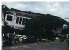
2006年5月26日インドネシアジャワ島中部地震によるRC2階建てオフィスの被害
