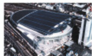
さいたまスーパーアリーナ。7階建ての建物が70メートル移動してアリーナが円形から長円形に変わる。
