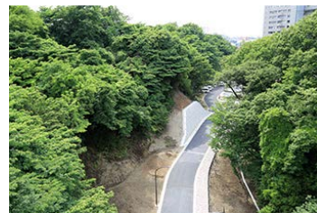
1年4ヶ月にわたる工事によりH28.6.1すずかけ台キャンパス外周道路が開通
