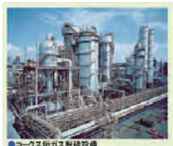
●コークス炉ガス脱硫設備 燃焼炉ガス分析・ 操業アクティブ制御 大型焼却炉:1740基(国内)
