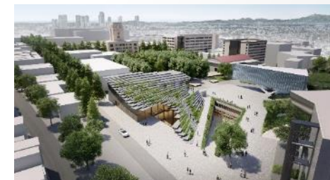
提供：隈研吾建築都市設計事務所
