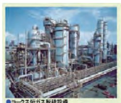
燃焼炉ガス分析・ 操業アクティブ制御 大型焼却炉: 1740基(国内)
