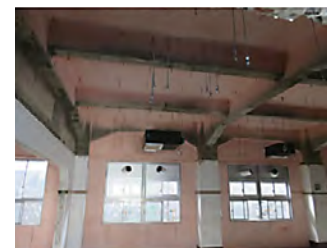
本館改修工事 (VI期) 断熱材 (ピンク色部分が断熱材)
