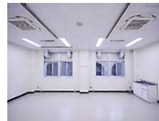
本館改修工事 (VI期) 施工後
