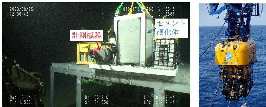
左：水深約3,500mの海域にセメント硬化体及び計測機器を設置した様子
