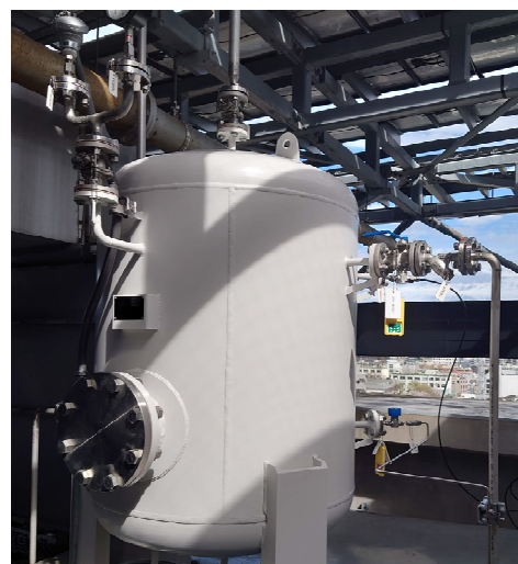
図4 再生可能エネルギー水素／廃プラスチック水素等を混合するリザーバ
