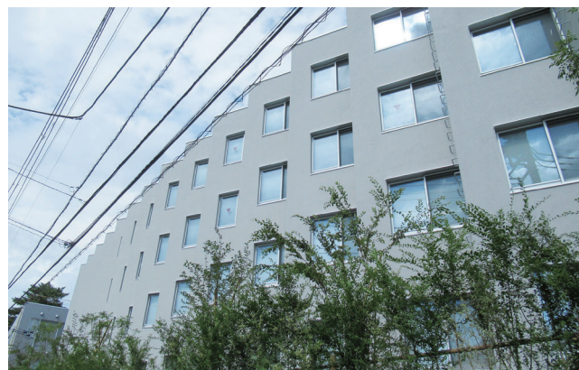
オープンした「緑が丘ハウス」の外観
